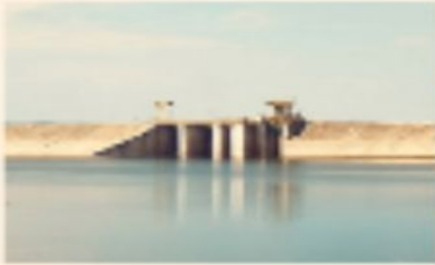
تجمع مياه الأمطار
